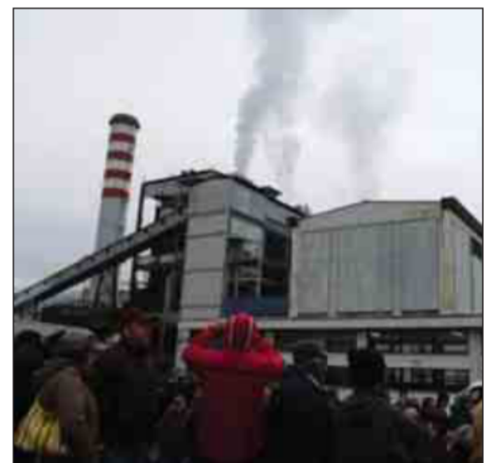
La centrale del Mercure
